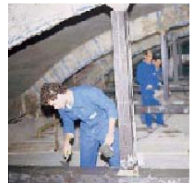
Заливка MAPEGROUT HI-FLOW в металлическую опалубку
