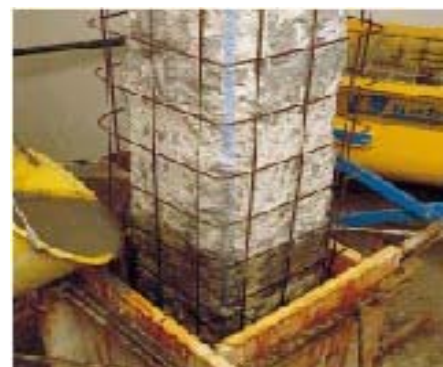
Вливание раствора в опалубку
