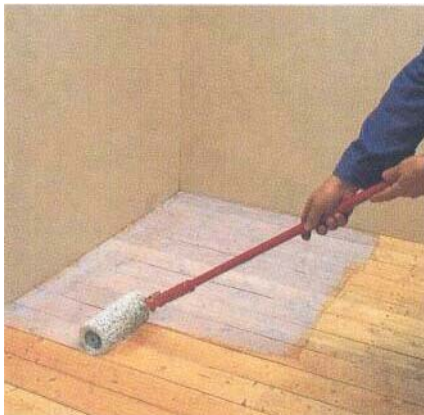
1 - Нанесение валиком грунтовки MAPEPRIM SP
