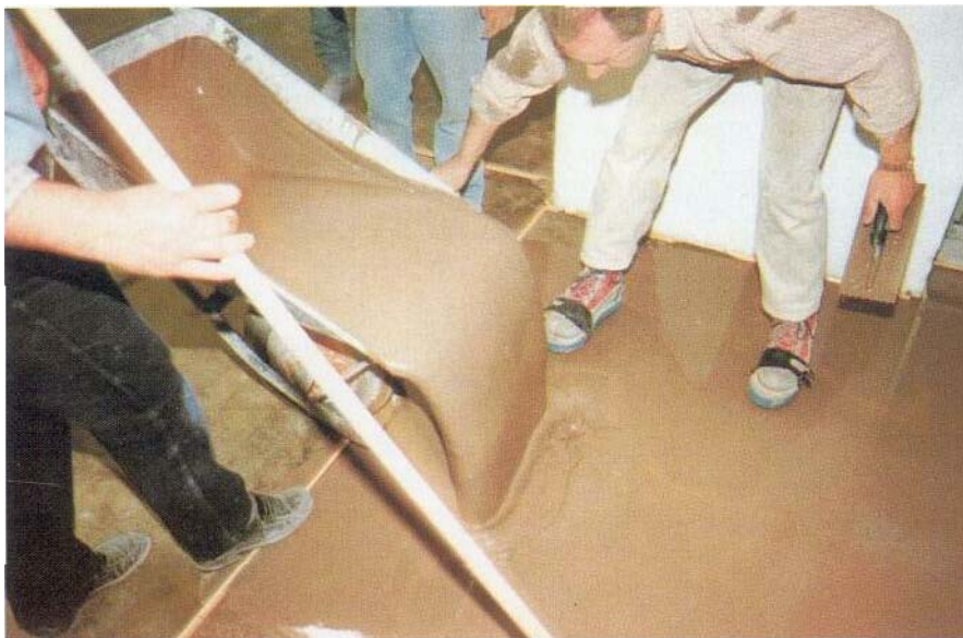
Выравнивание ULTRAPLAN старых полов
