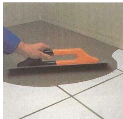
5 - Нанесение ULTRAPLAN на существующие керамические полы
