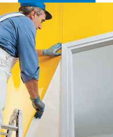
Приклеивание листов настенного покрытия при помощи Adesilex MT32
