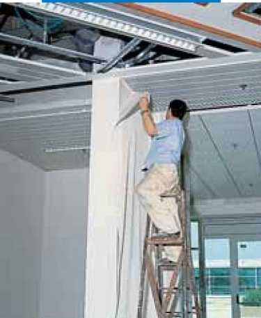
Приклеивание настенного покрытия в офисном здании
