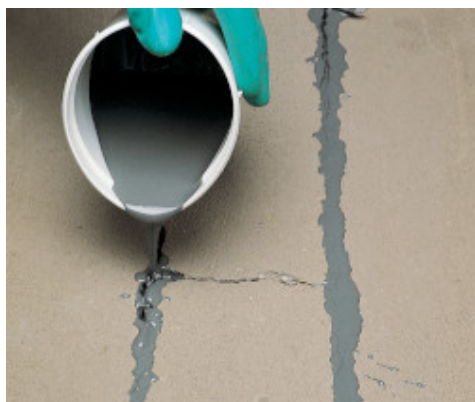
Ремонт трещины в цементной стяжке с помощью Eporip
