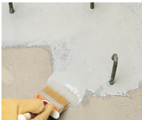
Нанесение Eporip кистью на рабочий шов бетонирования
