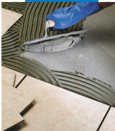
Укладка плитки ординарного обжига в качестве полового покрытия
